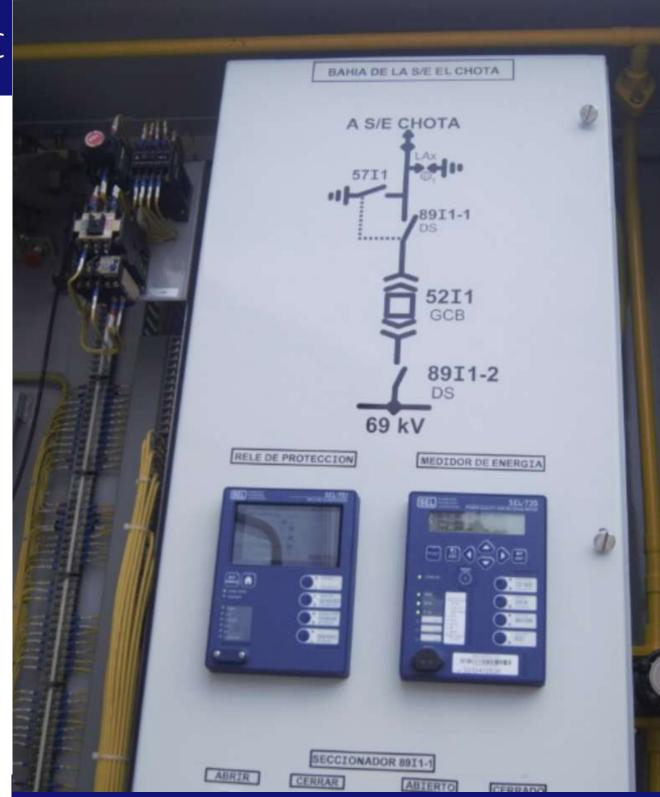
Los equipos SEL permiten contar con mediciones precisas y confiables, con lo cual se pueden identificar anomalías en el sistema de potencia y mitigar su impacto
